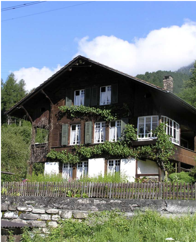
z.B. Stocki, erbaut 1772, Fenster EG links wurde ersetzt
